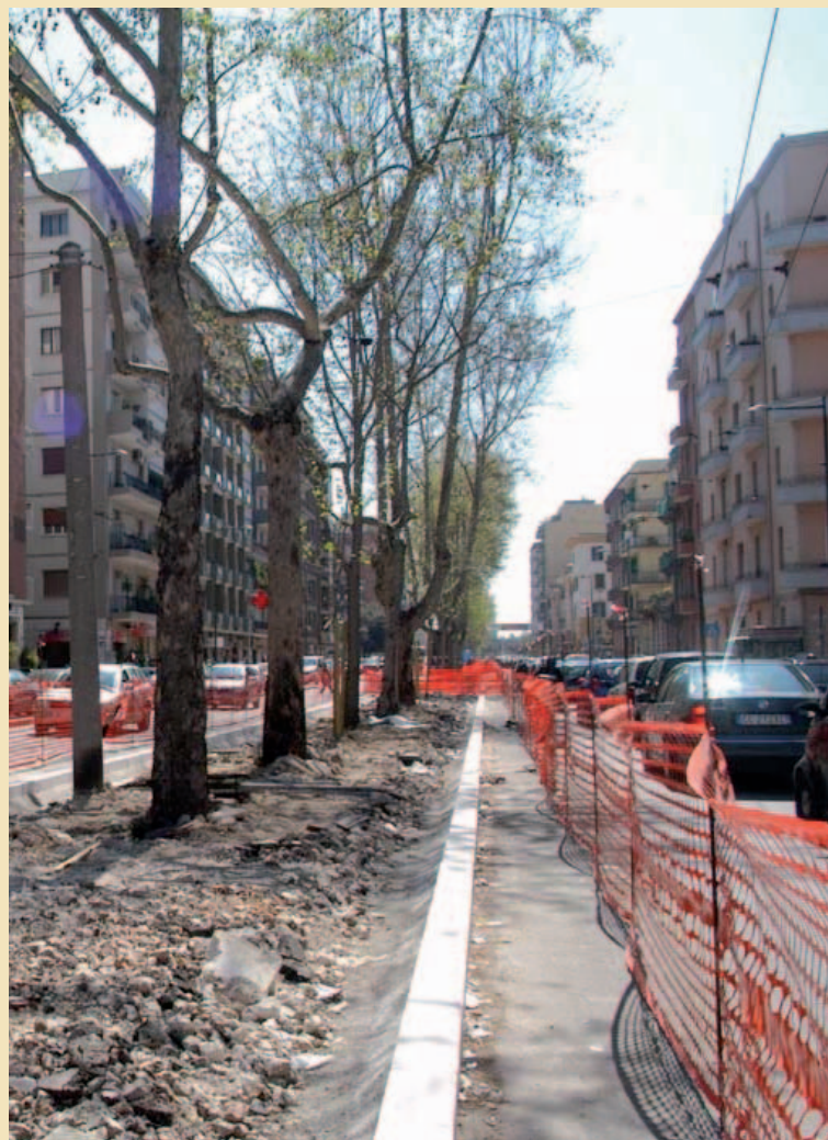
Il cantiere della pista ciclabile in viale Unità d'Italia. Disposte correzioni ai lavori [Foto Turi]
